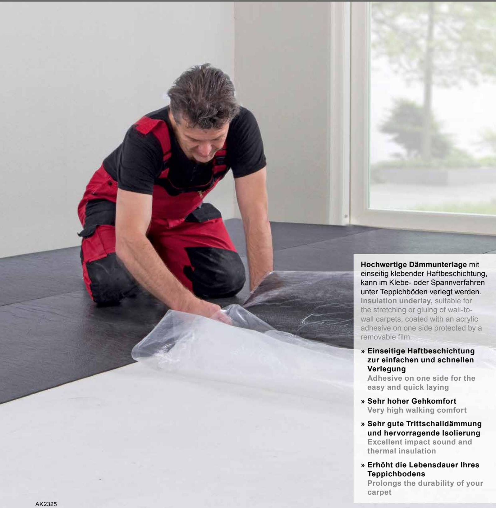
**Hochwertige Dämmunterlage** mit einseitig klebender Haftbeschichtung, kann im Klebe- oder Spannverfahren unter Teppichböden verlegt werden.
